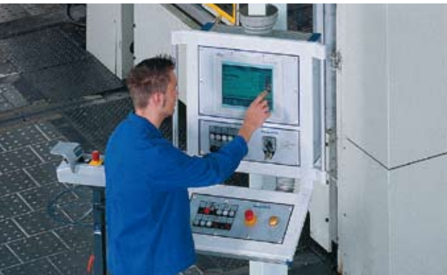
Bedienpult der Gesamtanlage
