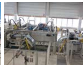
Bandanlage in Langbauform
